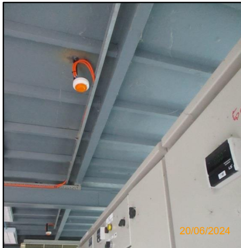
รูปที่ 2-43 อุปกรณ์ตรวจจับการรั่วไหลของเอทานอล และตรวจจับเปลวไฟ
