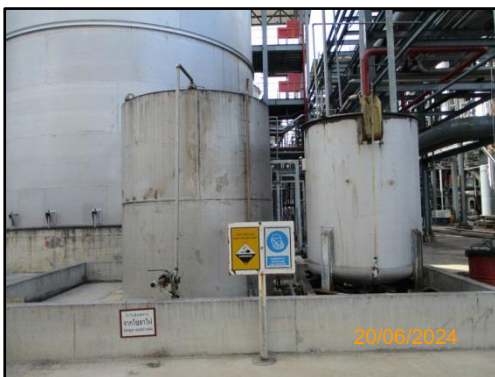
รูปที่ 2-51 ถังเก็บ NaOH
