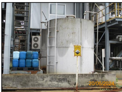
รูปที่ 2-52 ถังเก็บ H_2SO_4
