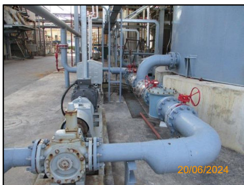
รูปที่ 2-47 ปั๊มสูบกากน้ำตาล
