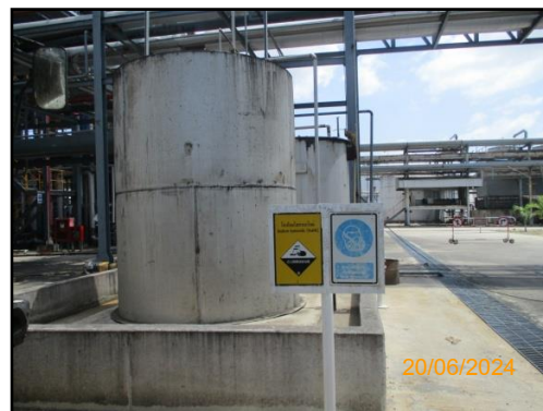
รูปที่ 2-51 ถังเก็บ NaOH
