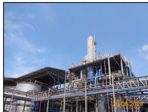
รูปที่ 2-15 ถังหมัก หกกลั่น และหอกลั่นน้ำที่เป็นระบบปิด
