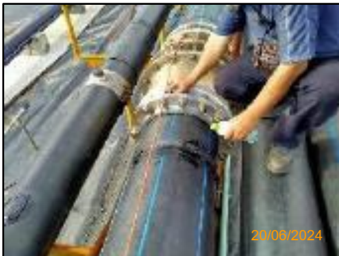
รูปที่ 2-49 การติดตั้งอุปกรณ์เพื่อความปลอดภัยของระบบท่อลำเลียงก๊าซชีวภาพ
