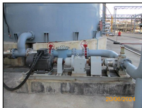
รูปที่ 2-47 ปั๊มสูบกากน้ำตาล
