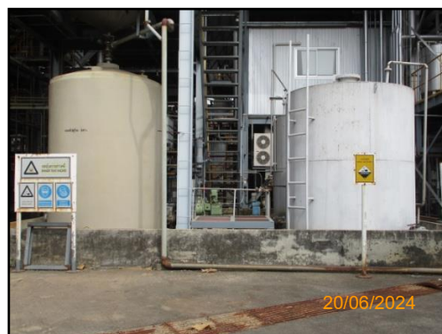
รูปที่ 2-52 ถังเก็บ H_2SO_4
